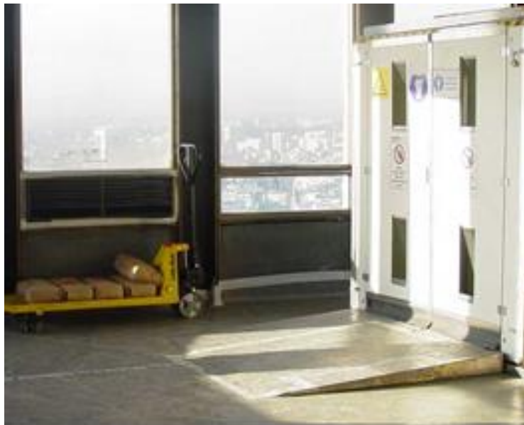
Transpalette et forme de pente pour accéder au sas matériel
